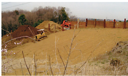
大量の土砂を搬入し整地工事中のがけ地(谷戸) 現在の緑地(下写真)は想像もできない (2004年頃撮影 写真提供 かわさき自然と共生の会)
