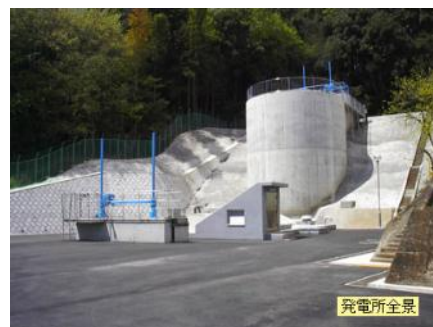
設備は2006年に更新された
