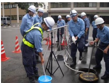
取り出した装置を組み立て、給水する様子 （写真提供：川崎市上下水道局）
