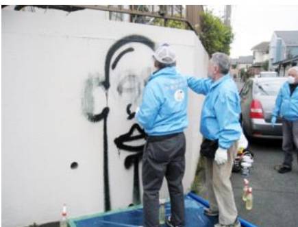
▼落書き消し作業中
