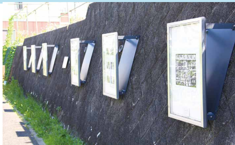
片平川沿いの遊歩道脇の擁壁に6基のパネルが設置され、アート作品が展示されている
